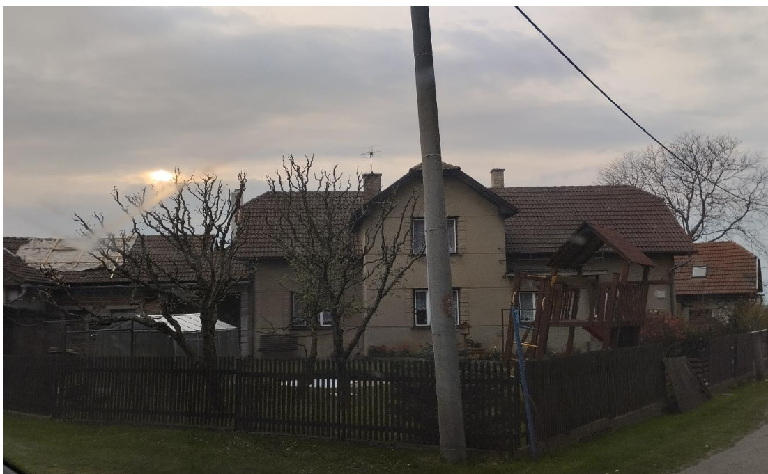
Foto 4: Poškozená střecha, dětský domeček a plot v obci Nejepín. Autor: Robin Duspara (CTRA).
